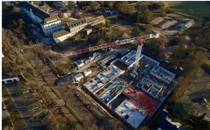
Die Baustelle an der Nordkanalallee liegt im Zeitplan.
